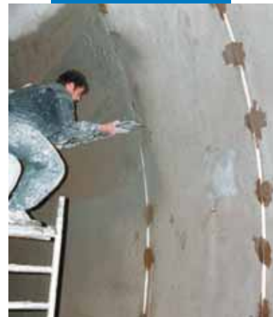
Εφαρμογή επιχρίσματος με πήχη
