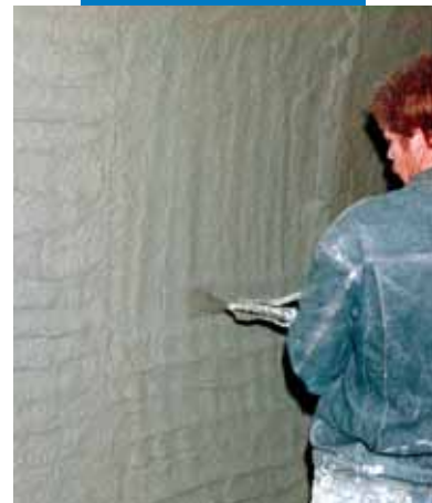
Εφαρμογή του Nivoplan με ψεκασμό
